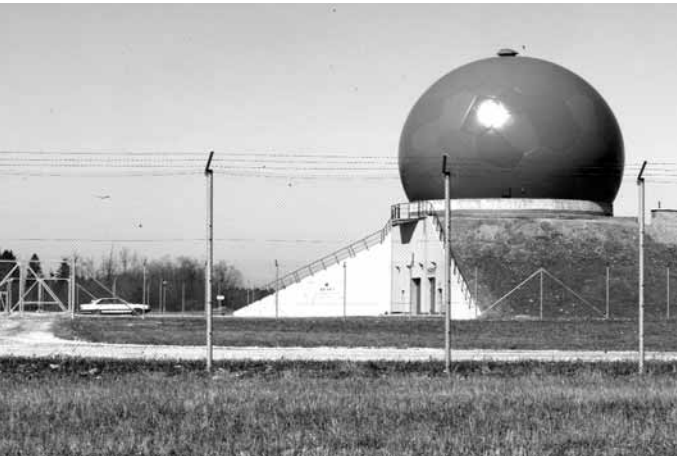
KOLMEMÕOTMELINE ÕHUSEIRE PRIMAARRADAR VÕIMALDAB NÄHA LIIKUVAT OBJEKTI 450 KILOMEETRI KAUGUSELT
